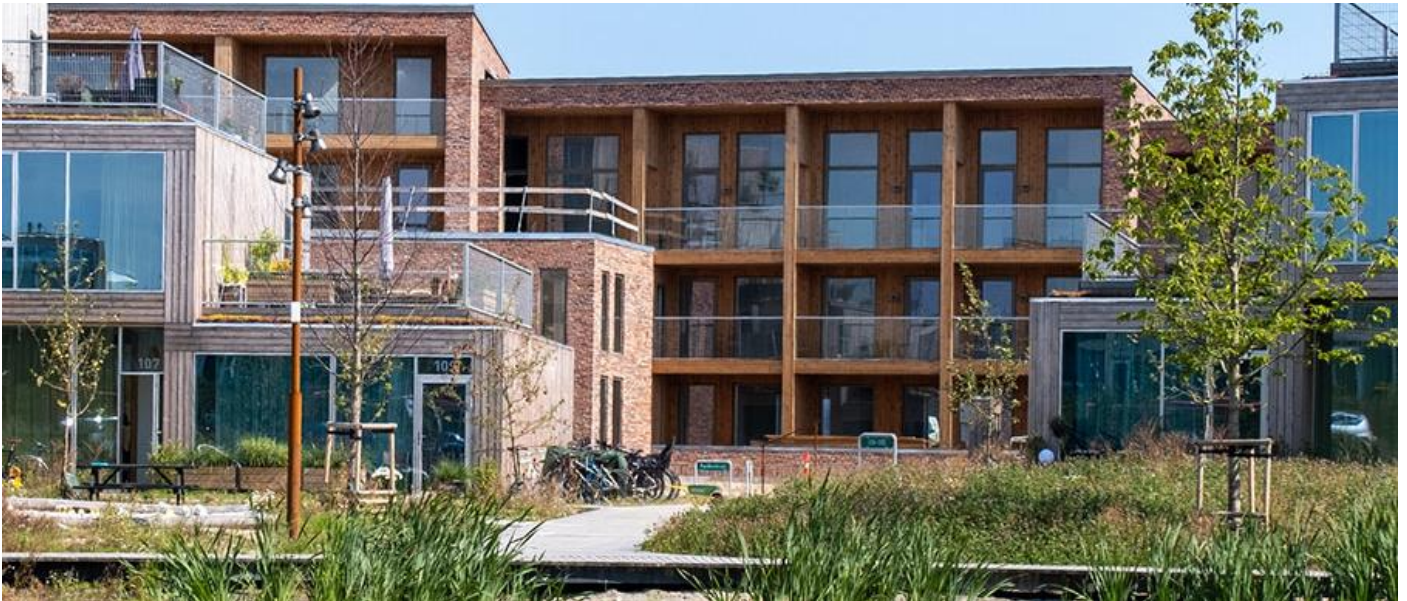
"Svinget" og "Sneglehusene" opførelse af hhv. 66 og 93 boliger i Nye i totalentreprise
